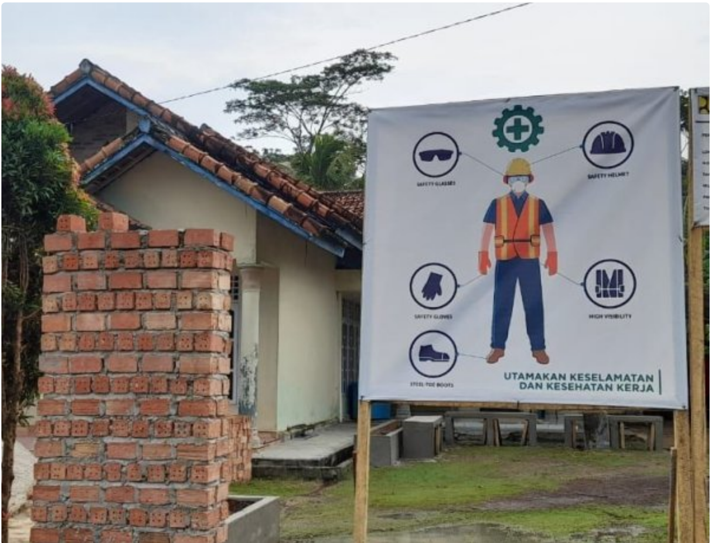
Proyek Infrastruktur Hunian Hijau di Mesuji
