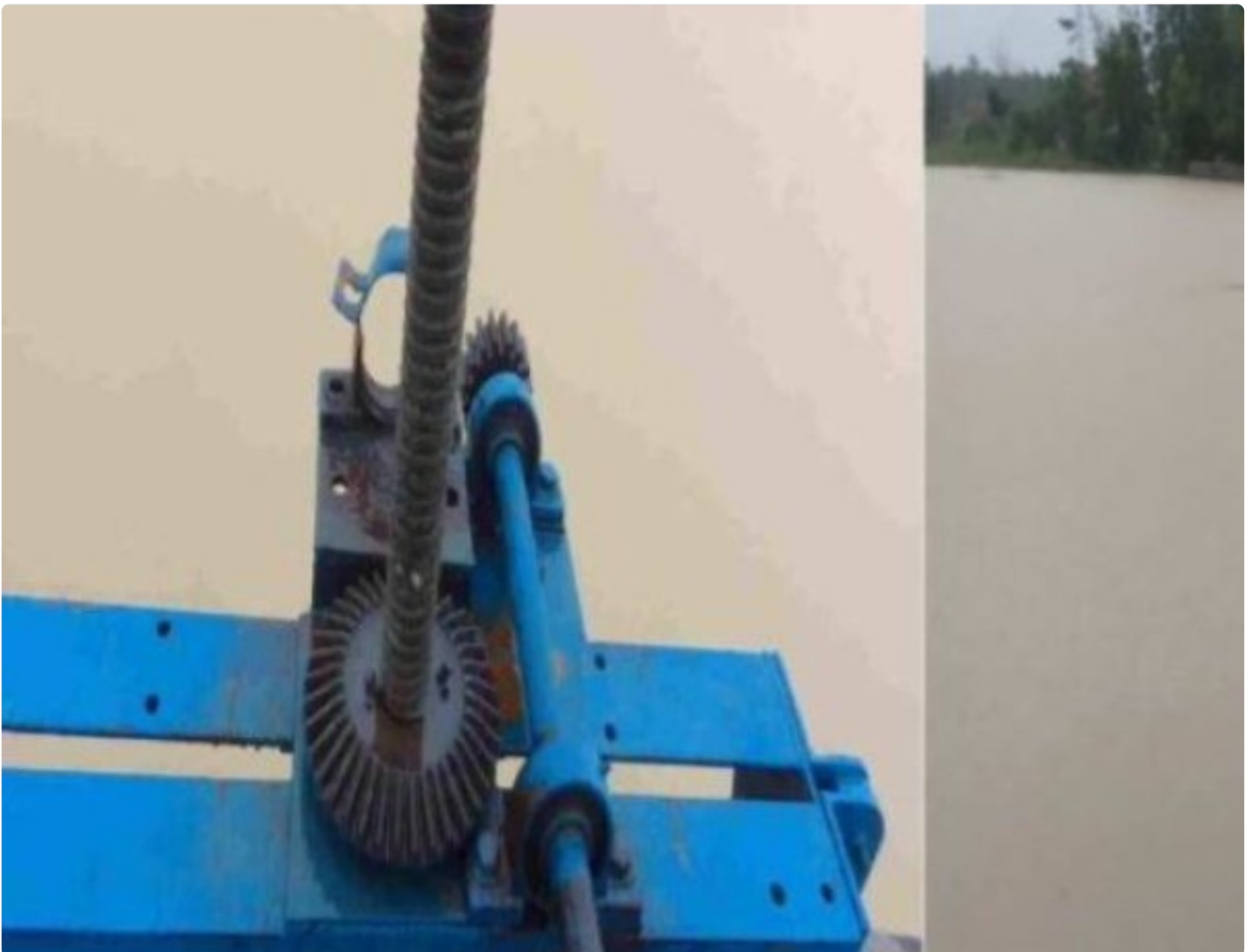
Pintu air Albaret Simpang Mesuji
